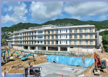
3 平成23年 新病棟建設工事着工
